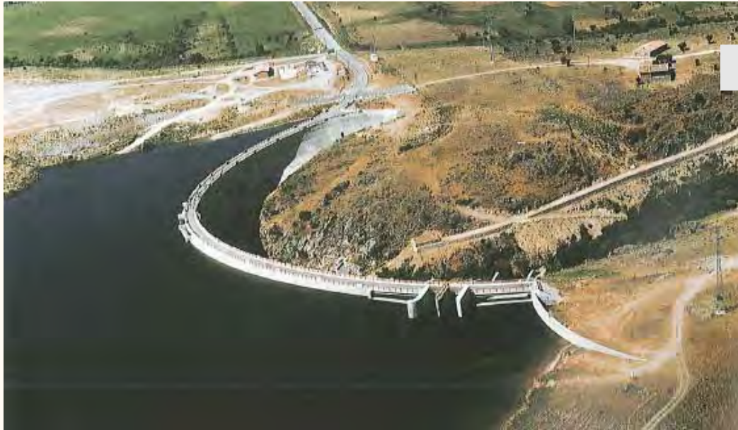
Presa de Pontón Alto (Segovia).
