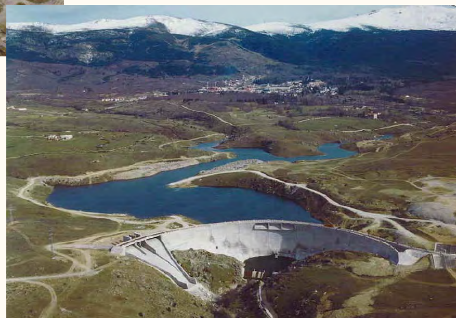
Vistas aéreas de la presa de Pontón Alto (Segovia).
